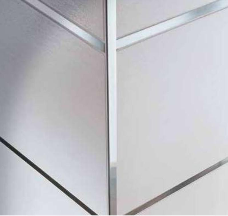
I profili **KERAJOLLY** proteggono i bordi delle piastrelle da urti ed impatti meccanici, permettendo grazie ai numerosi colori di effettuare accoppiamenti cromatici in abbinamento con i rivestimenti e le fughe e finiture particolari con l'utilizzo dei colori più intensi eventualmente coordinati con i listelli **LISTEC**.
